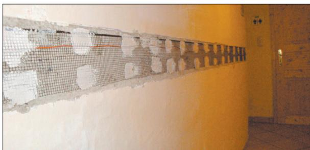
Anbringen des Netzgitters (Pluspol) zur Trockenlegung der Mauer.
